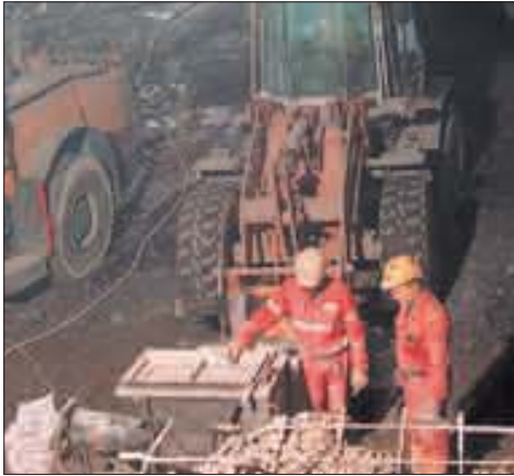
Ein Erkundungsstollen der BEG in Brixlegg im Rahmen der Unterinntaltrasse. Foto: BEG
