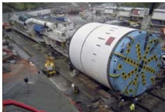
4 TBM-S mit Hochleistungsnachläufer nach 94/4/EG (ATEX) (Robbins GmbH)
